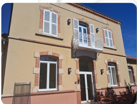
Balcon de l'école repeint
