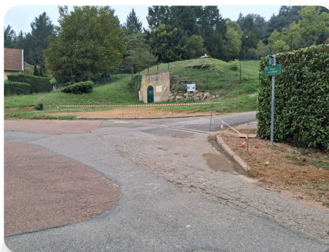
Pose de bordures au Château d'eau
