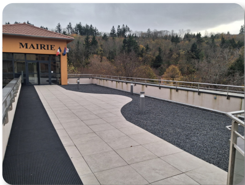
Aménagement terrasse de la mairie
